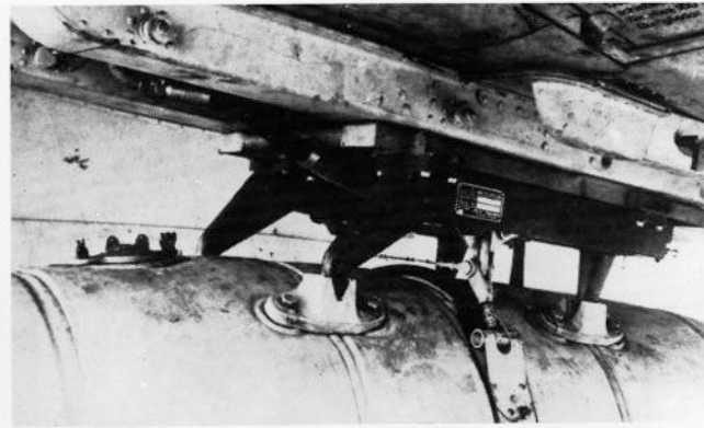
Ojedinělé tovární fotografie letounu Hs 129B-1 s podvěšenou přídavnou nádrží. Za pozornost stojí snímatelný univerzální rám pod trupem, na který se montovaly i závěsníky pro pumy (sbírka M. Velka) A unique factory shot of an Hs 129B-1 with jettisonable fuel tank attached. Note the removable universal frame under the fuselage, serving also for attachment of bomb racks (M. Velek Collection)
